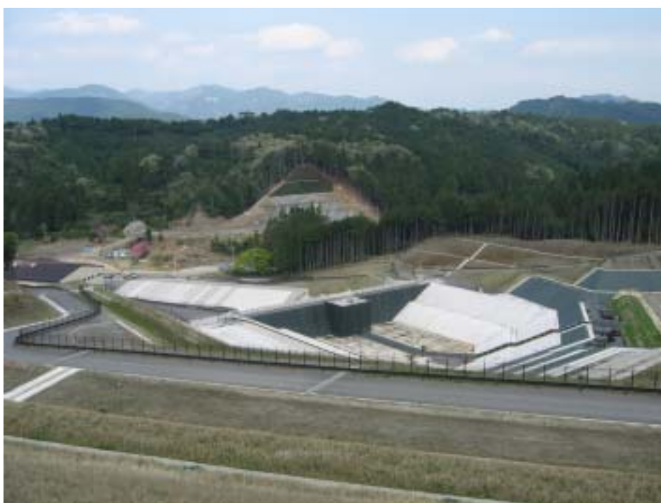
写真5 処分場下流側の様子
